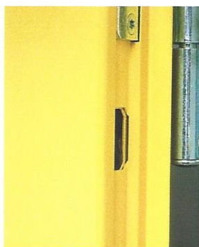
Dubbla tappar i bakkant ökar säkerheten.
